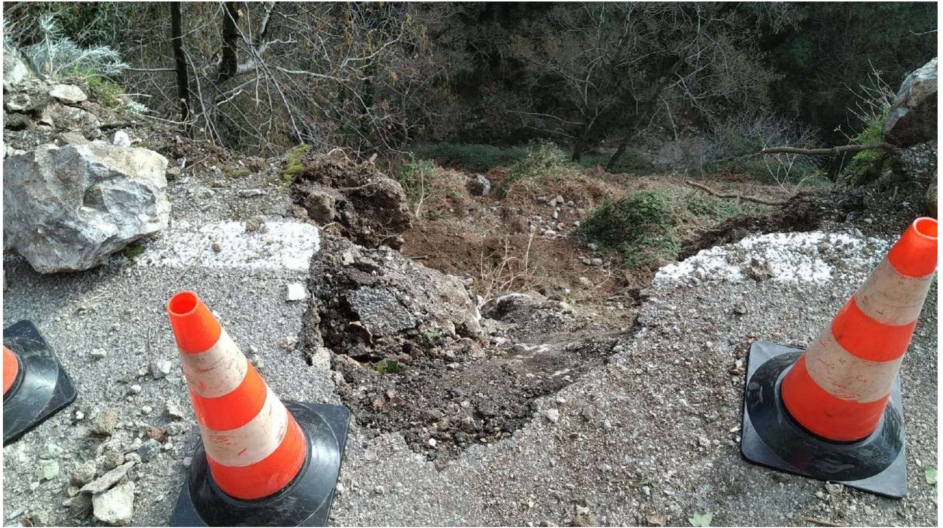
SR 366 – Agerolina – Km 5+250 circa – situazione dopo il crollo – Mattina del 06/03/2022 - prima dell'installazione dei New Jersey in calcestruzzo
