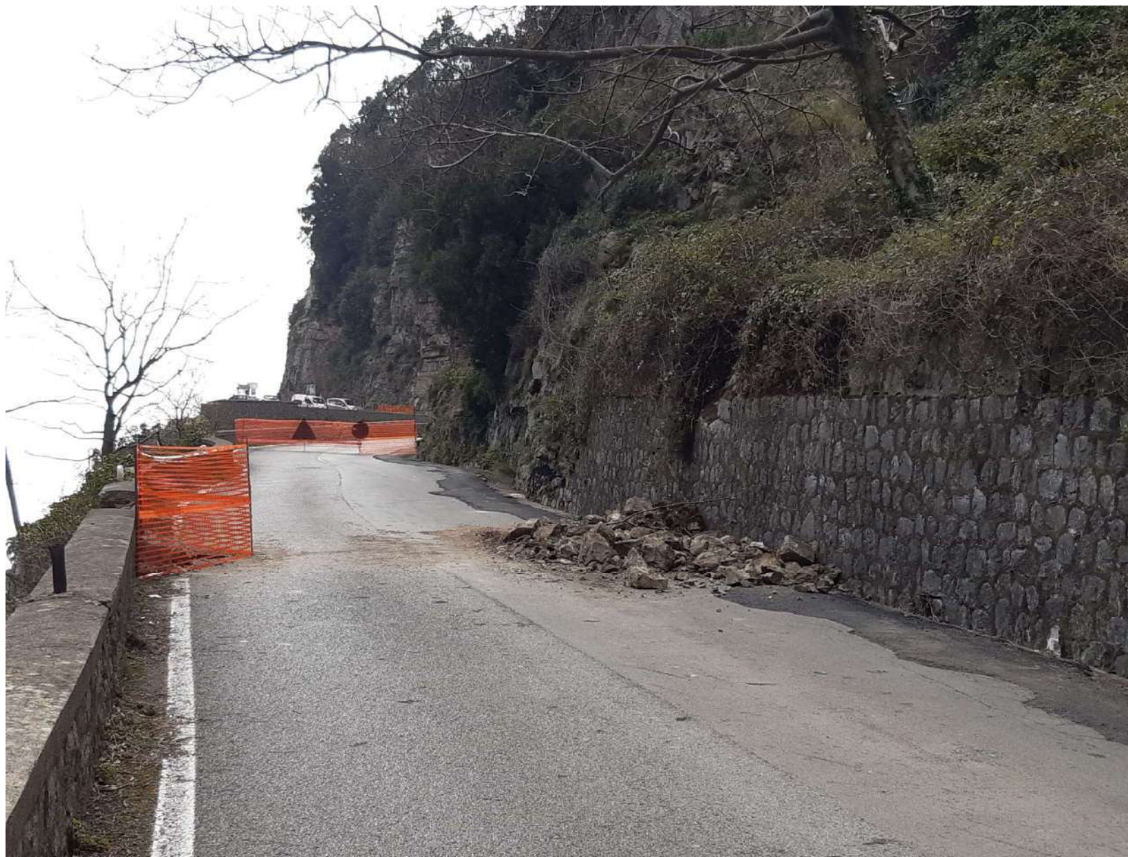
SR 366 – Agerolina – Km 5+250 circa – situazione dopo il crollo – Mattina del 06/03/2022 - prima dell'installazione dei New Jersey in calcestruzzo
